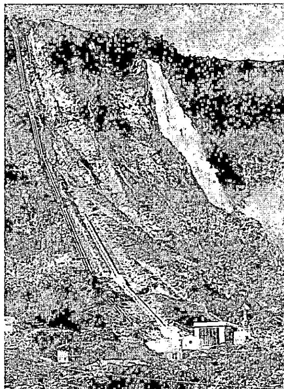
Salto de Guadalupe y centrales Guadalupe I y III, 1966
